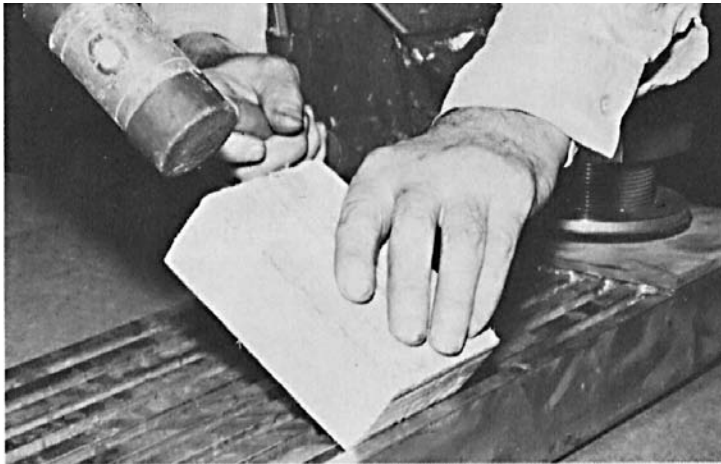
FIG. 27 Enderezando los tubos con un bloque de madera y un mazo
